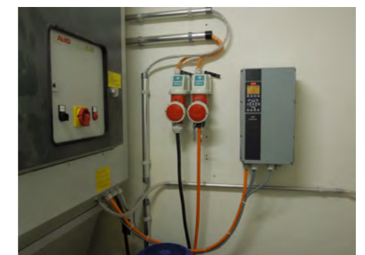
Nachrüstung Mobil-Jet mit Frequenzumrichter
